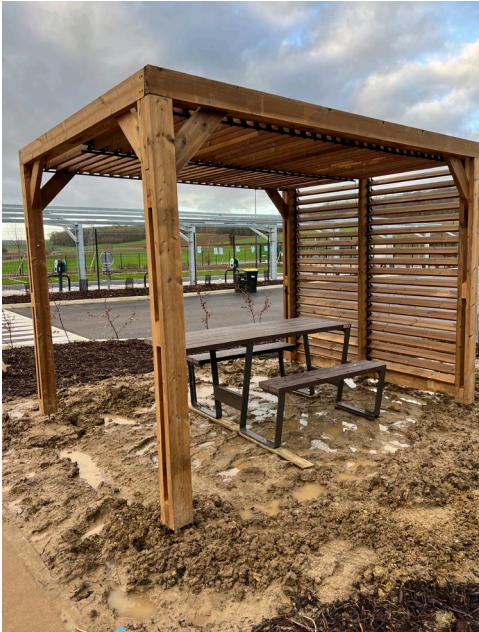
Espace détente en cours d'aménagement- Bresles (60)
