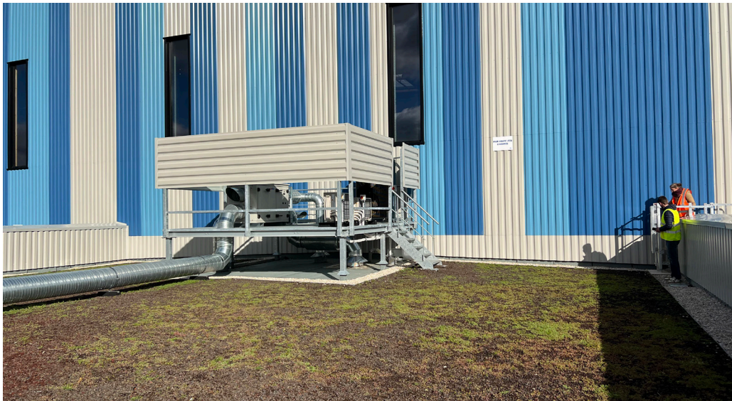
Toiture végétalisée - Bresles (60)
