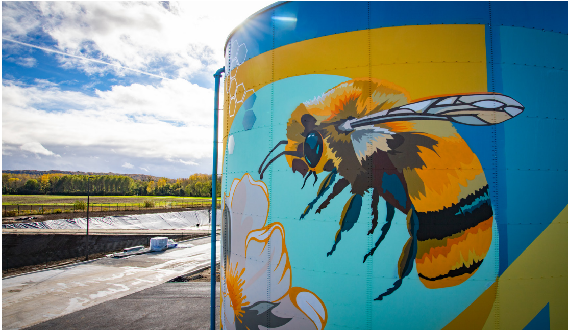
Cuve sprinkler à Bresles (60)
