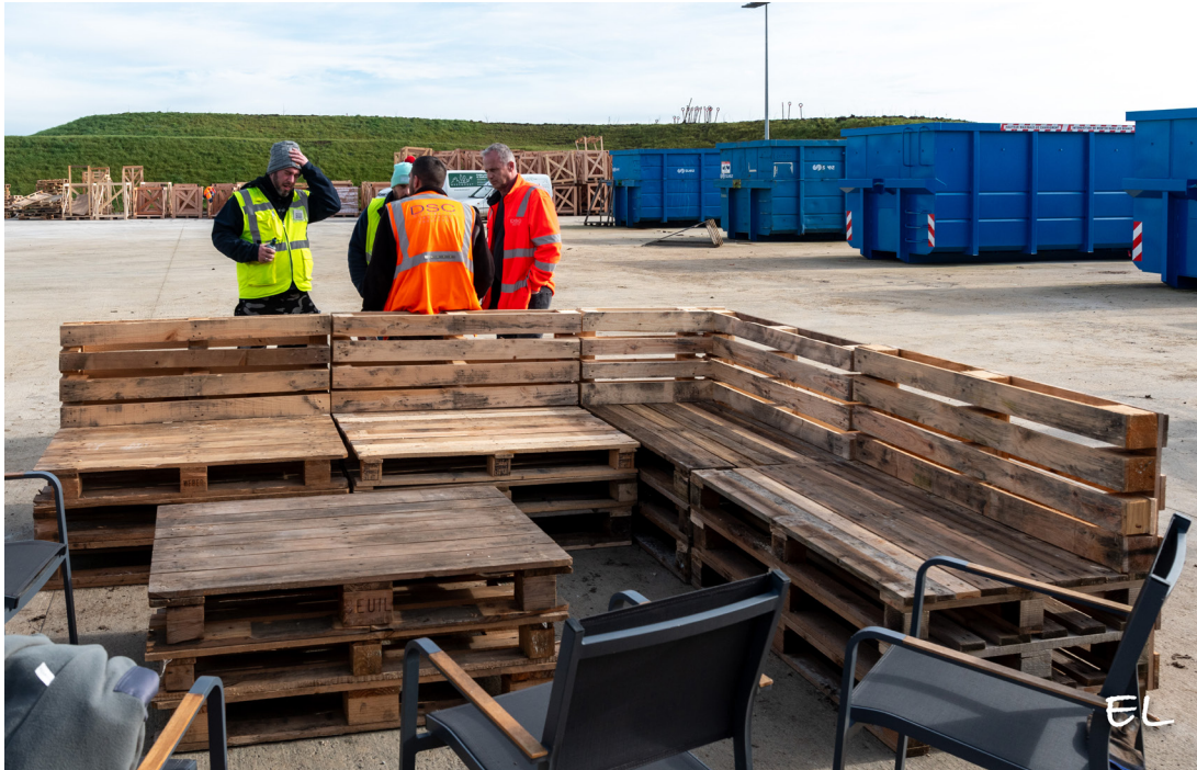
Construction du mobilier extérieur - Bresles (60)
